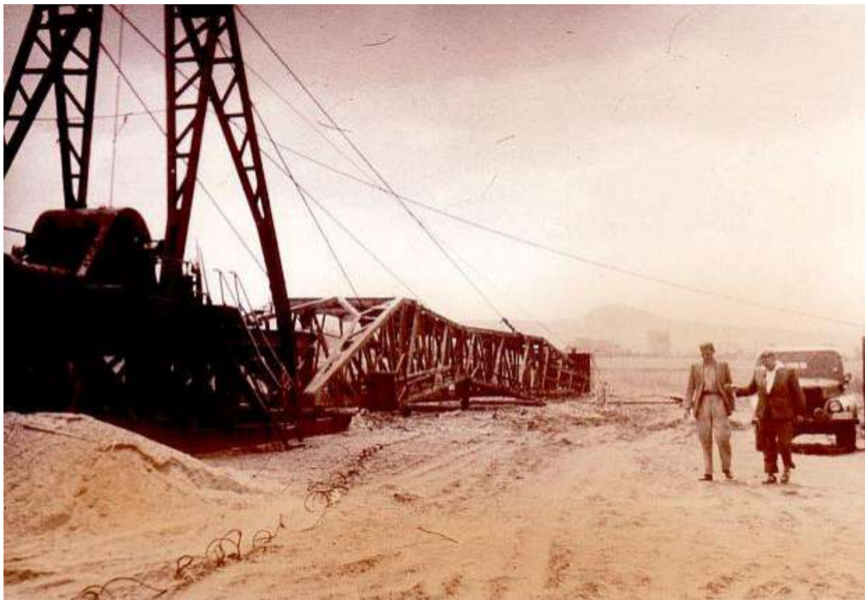
5. ábra. A fúrótorony felállítása
