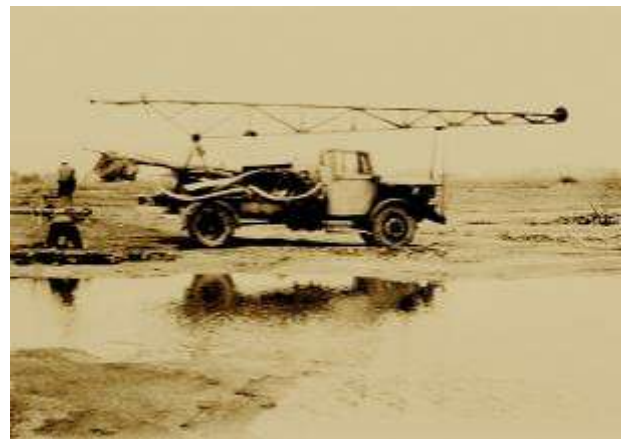
2. ábra. Hazai gyártású önjáró fúróberendezés az 1960-as évekből
